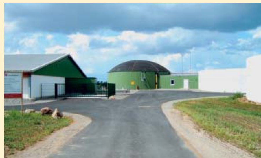
Neubau einer Biogasanlage (im Kreis Bad Doberan) mit einem Anschlusswert von 160 kW und eines Schweinemaststalles mit 3.000 Plätzen; Inbetriebnahme der Anlagen im Jahr 2004; Erweiterung der Biogasanlage auf 500 kW für das Jahr 2006 vorgesehen
