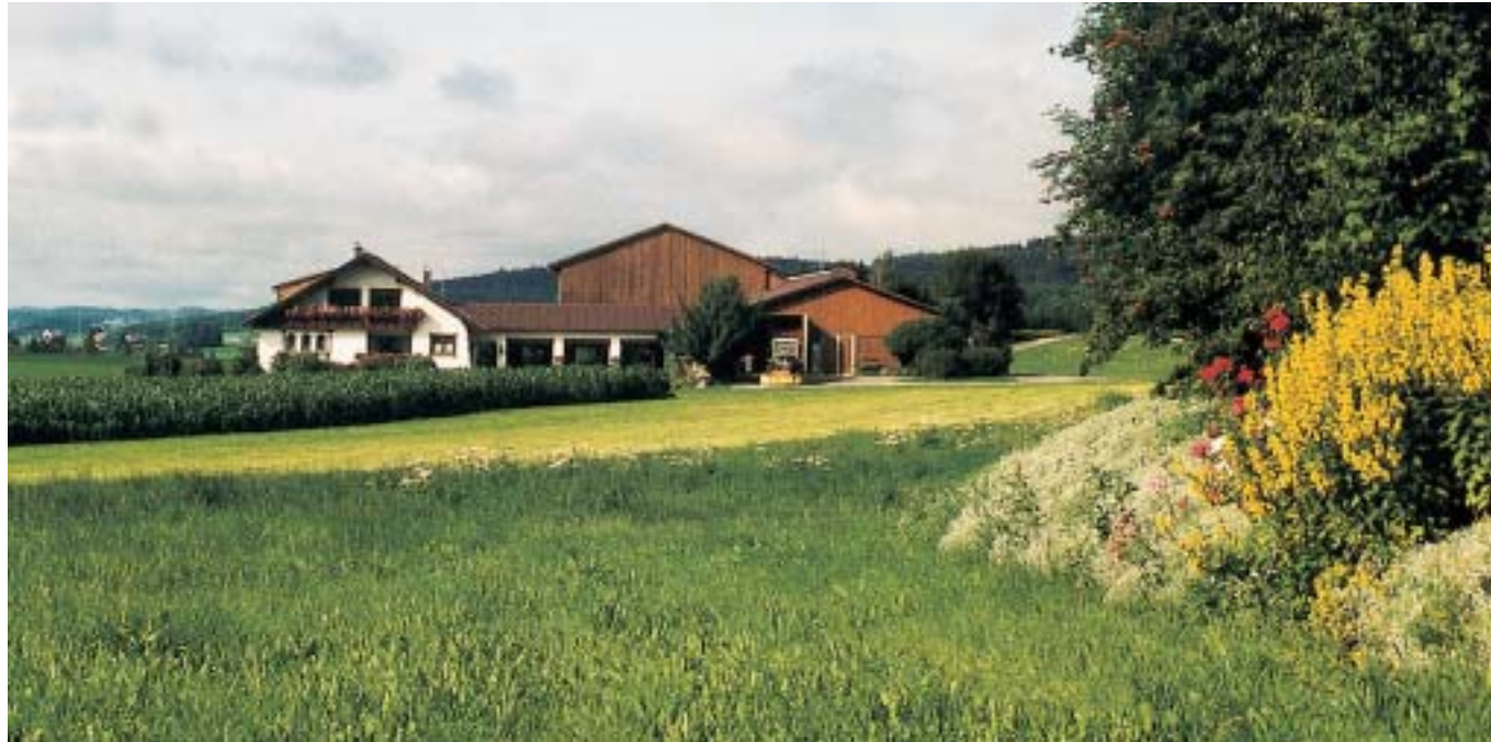
Sonderkreditprogramme der Landwirtschaftlichen Rentenbank: Eine wichtige Säule bei der Finanzierung von Betriebsübernahmen und Investitionen
